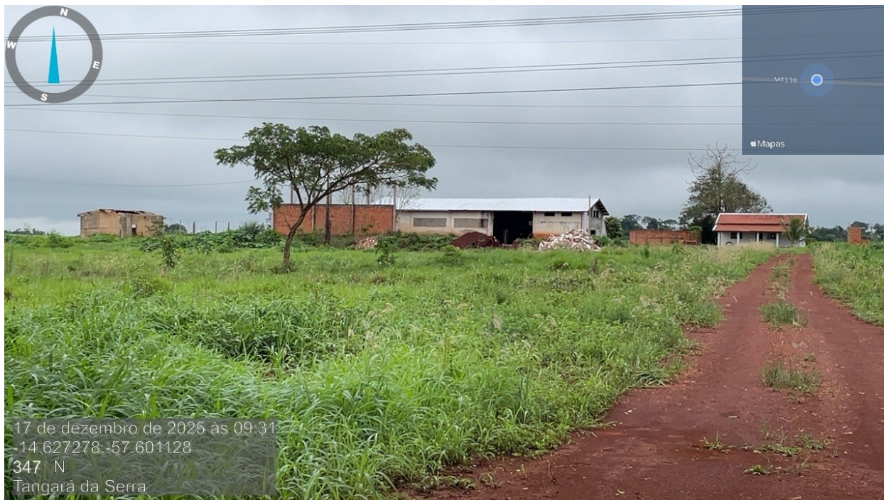
Figura 04 – Vista de frente – Rod. MT-358
