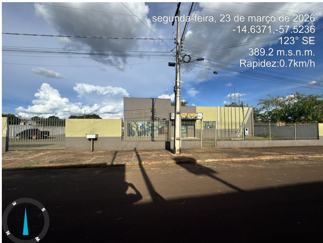
Figura 03 - Vista principal da edificação Fonte: Departamento de Estudos e Projetos/Seplan
