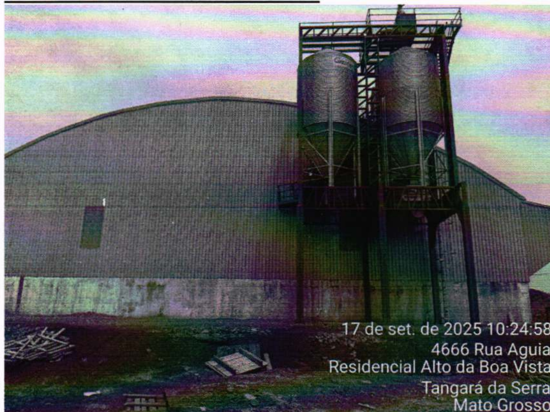
Figura 2: Lado esquerdo do barracão com o novo investimento, 2 silos para 20 toneladas cada, balança com capacidade de 700 KG, 1 triturador com produção de 10 a 12 toneladas hora.
