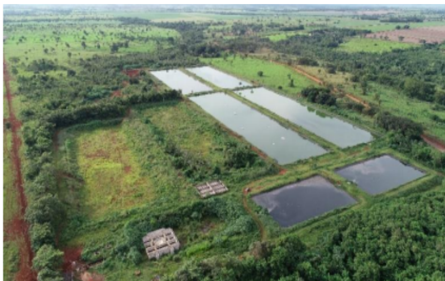
Figura 22 - Estação de Tratamento de Esgoto - ETE Ararão.
