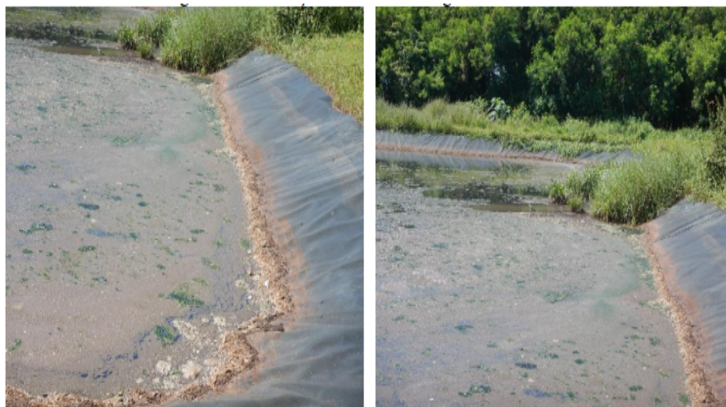
Figura 26 - Formação de espuma na lagoa anaeróbia 02.
