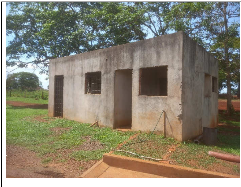
Foto 7.5 – Prédio administrativo do operador
