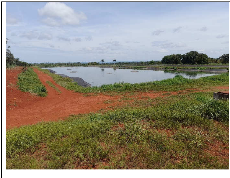
Foto 4.8 - Para solucionar o problema dos bolsões o fornecedor do geotextil deverá ser consultado.
