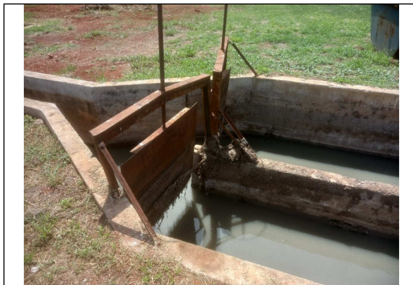
Foto 4.2 – 2 comportas existentes deverão ser substituídas e 2 comportas de montante deverão ser instaladas.
