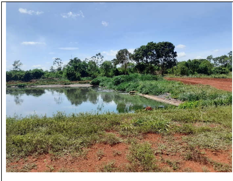
Foto 4.5 - Material flutuante da Lagoa anaeróbia deverá ser removido.
