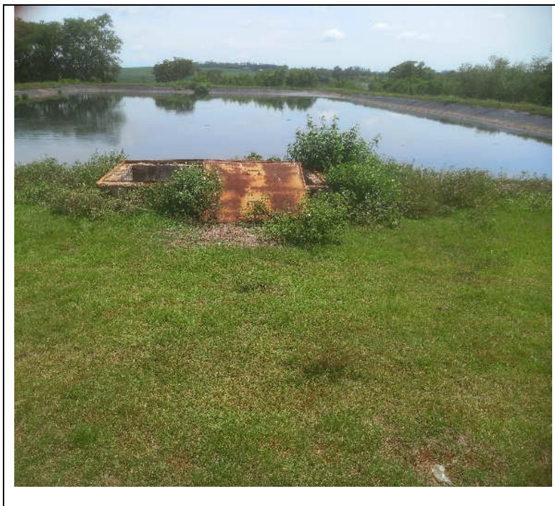
Foto 7.3 – Vegetação junto a caixas de processo
