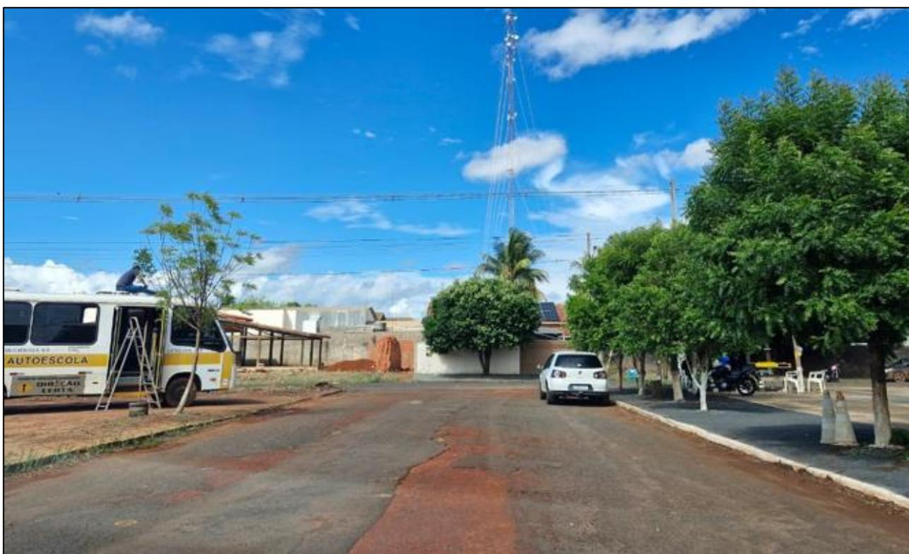
**Imagem 9.3.5:** Pavimento “CBUQ Faixa C” com espessura insuficiente para o tráfego viário.
