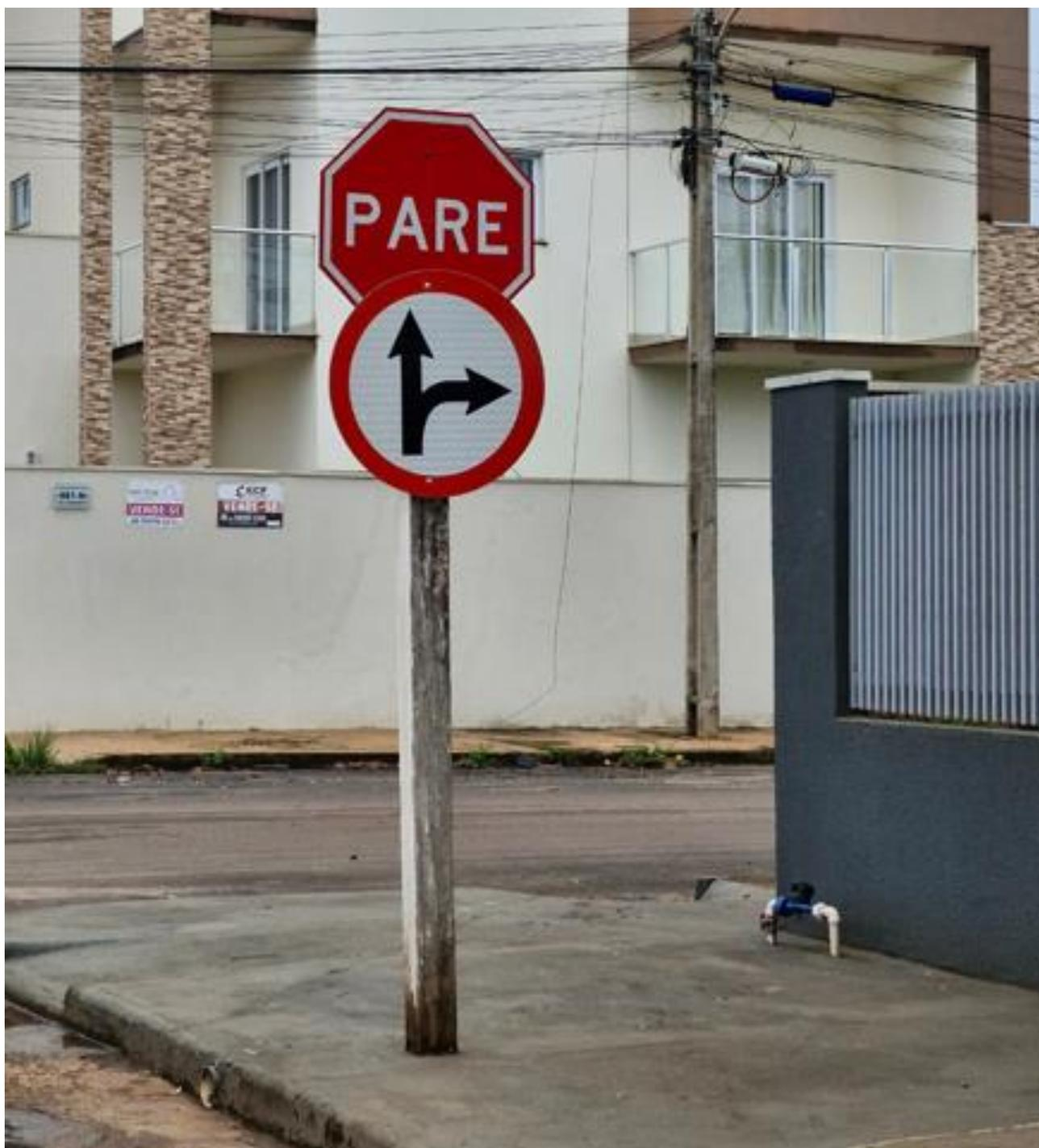
**Imagem 9.2.12:** Placa (R-25d) em desconformidade com o CONTRAN, sobre sinalização de sentido.
