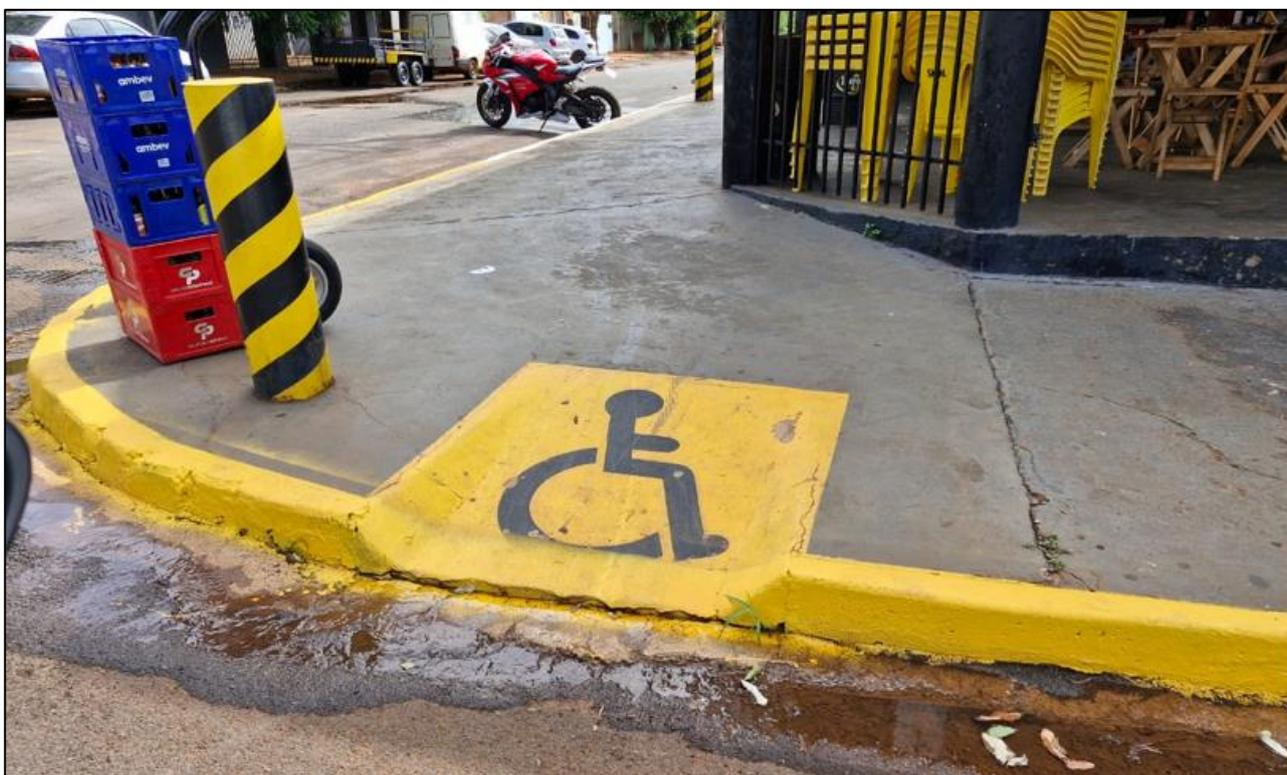
**Imagem 9.1.4:** Rampa peculiar, porém fora da Norma NBR 9050.
