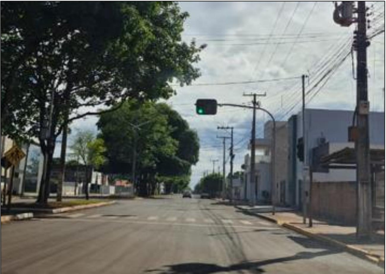
**Imagem 9.2.17:** Ausência de grupo focal repetidor e presença de contador (contagem regressiva) não recomendado no o Manual Brasileiro de Sinalização Semafórica.
