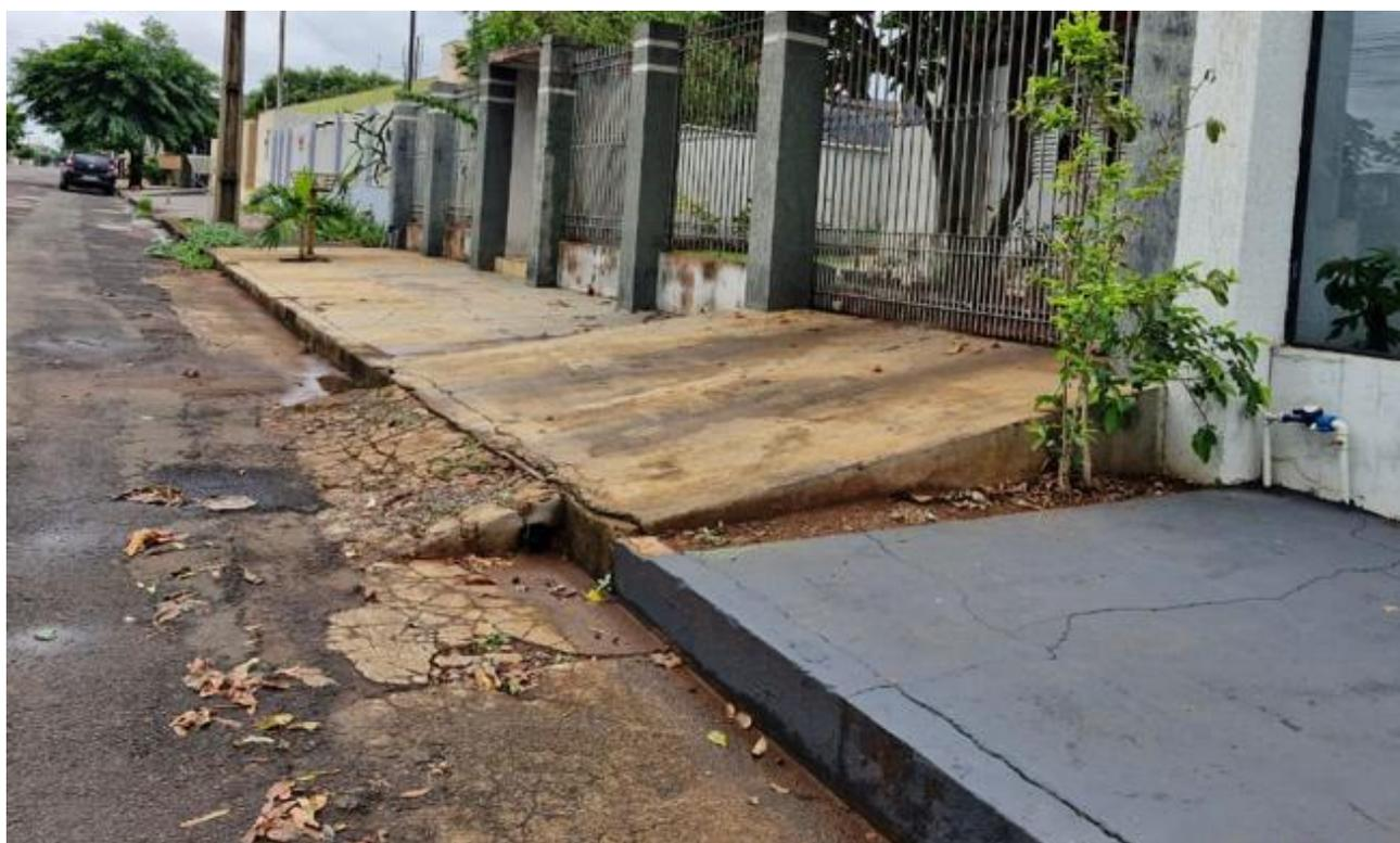
**Imagem 9.1.8:** Calçada com uso degrau e rampa ocupando área da sarjeta, situação encontrada em vários pontos da cidade.
