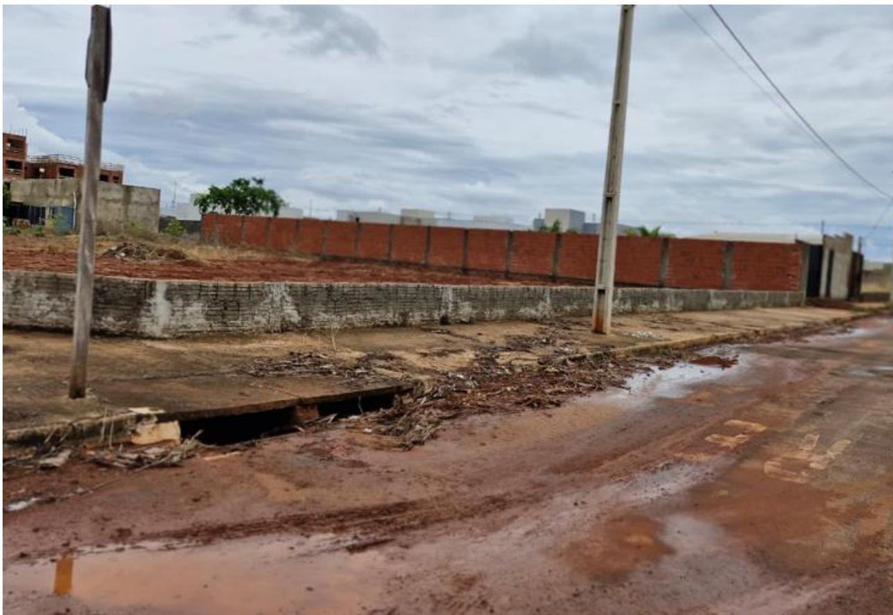
**Imagem 9.4.2:** Ausência de escoamento de águas superficiais e acúmulo de sedimentos situação encontrada em diversos locais da cidade.
