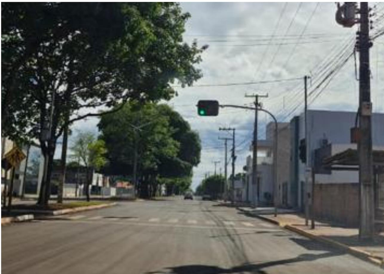
**Imagem 9.2.17:** Ausência de foco repetidor e presença de contador não recomendado no o Manual Brasileiro de Sinalização Semafórica.
