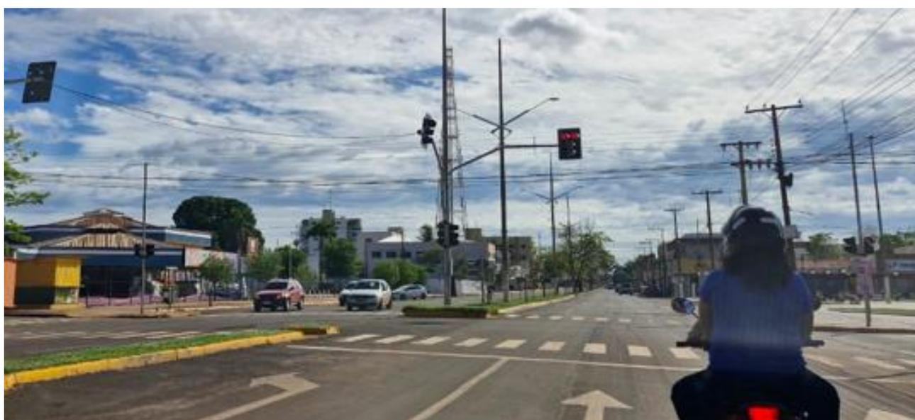
**Imagem 9.2.16:** Ausência de foco repetidor, em desacordo com o Manual Brasileiro de Sinalização Semafórica.
