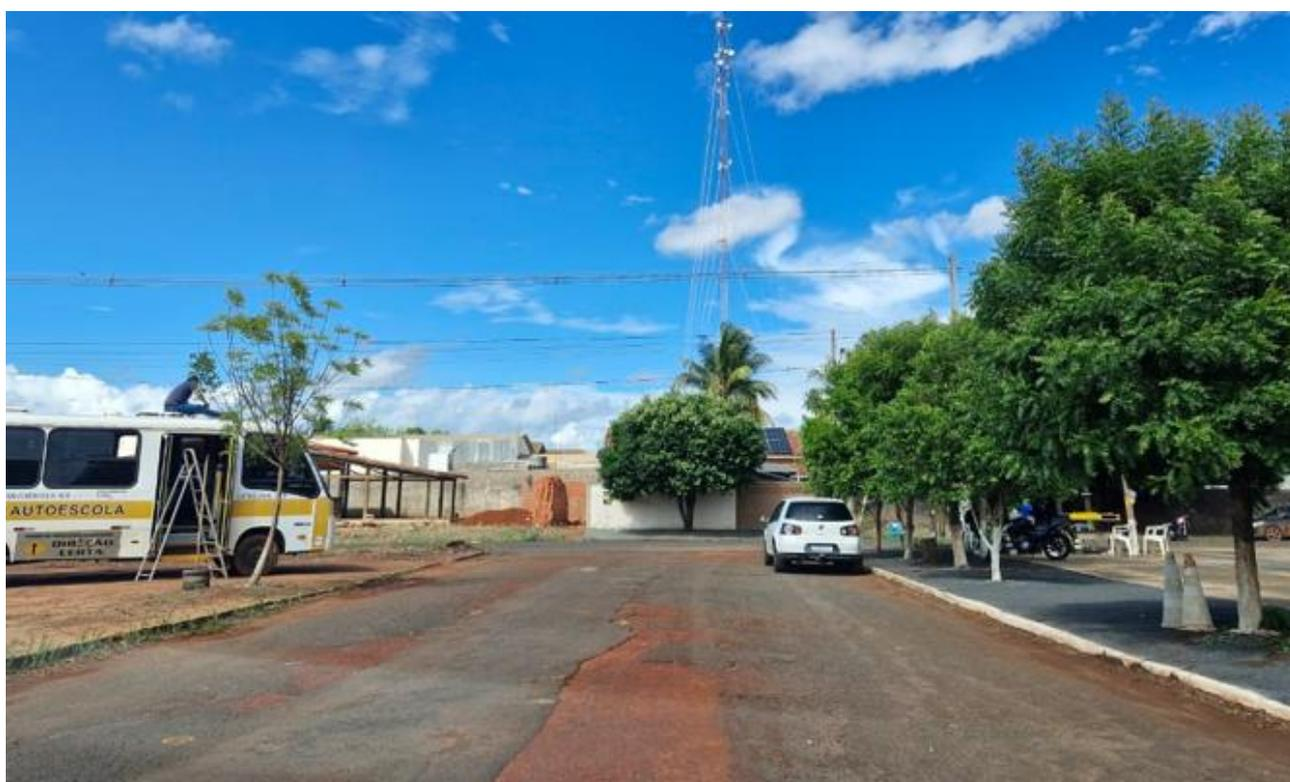
**Imagem 9.3.5:** Pavimento “cascinha” com espessura insuficiente para o tráfego viário.
