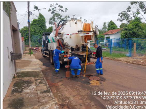
Foto 05 - Caminhão com equipamento para desobstrução de encanamentos.
