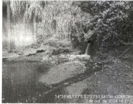
Ponto de lançamento de efluentes da ETE
